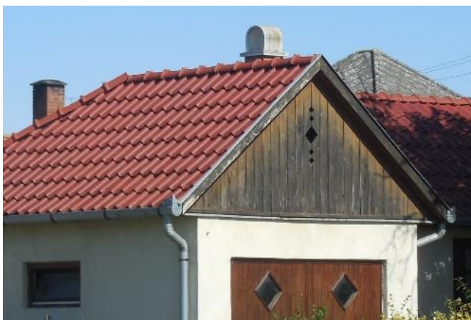
Deszkaborítású homlokzati fal.
