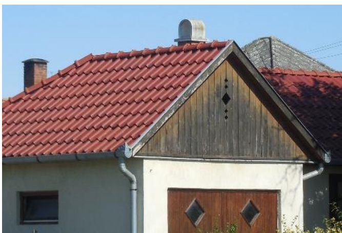
Deszkaborítású homlokzati fal.
